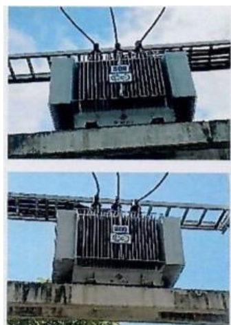
ภาพที่ 17 หม้อแปลงไฟฟ้า
